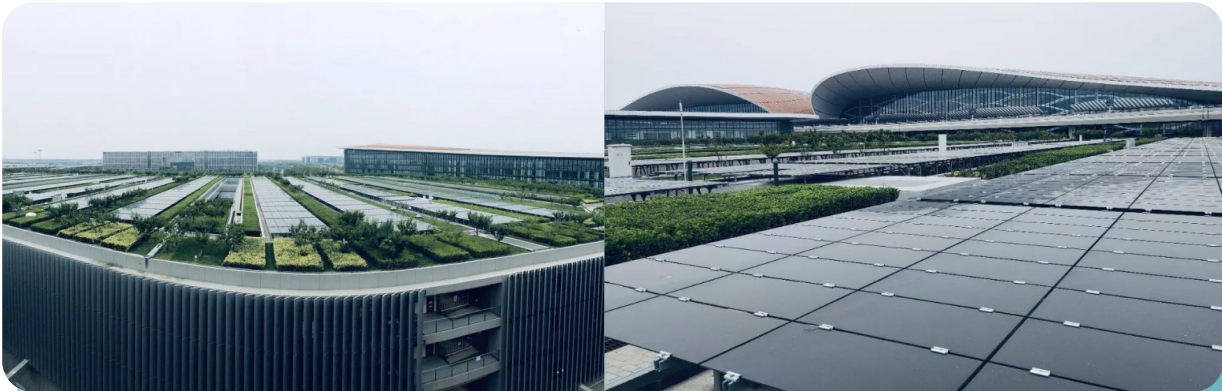
Carpark Building Solar Panel 停車樓光伏項目
